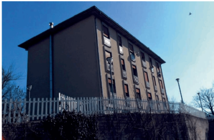
Il palazzo di edilizia residenziale pubblica in via Rubertelli 10 a Felina, dove sono partiti i lavori
