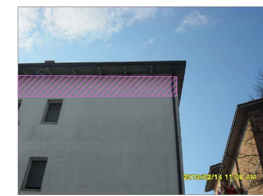
Intervento di Rimozione Intonaco, pittura, sarcitura lesione e rifacimento intonaco con elementi di rinforzo in fibra di carbonio bidirezionale.
