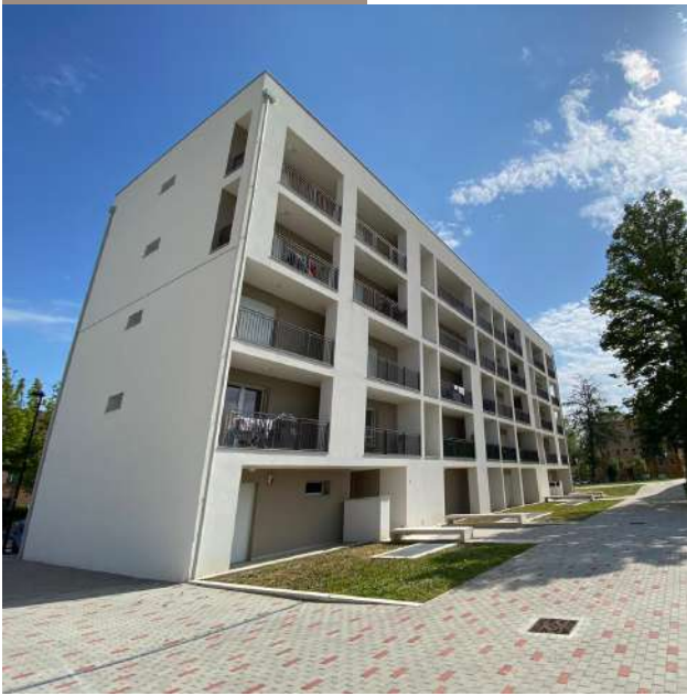
ACER Reggio Emilia Nuove palazzine di edilizia residenziale pubblica, in via Compagnoni
